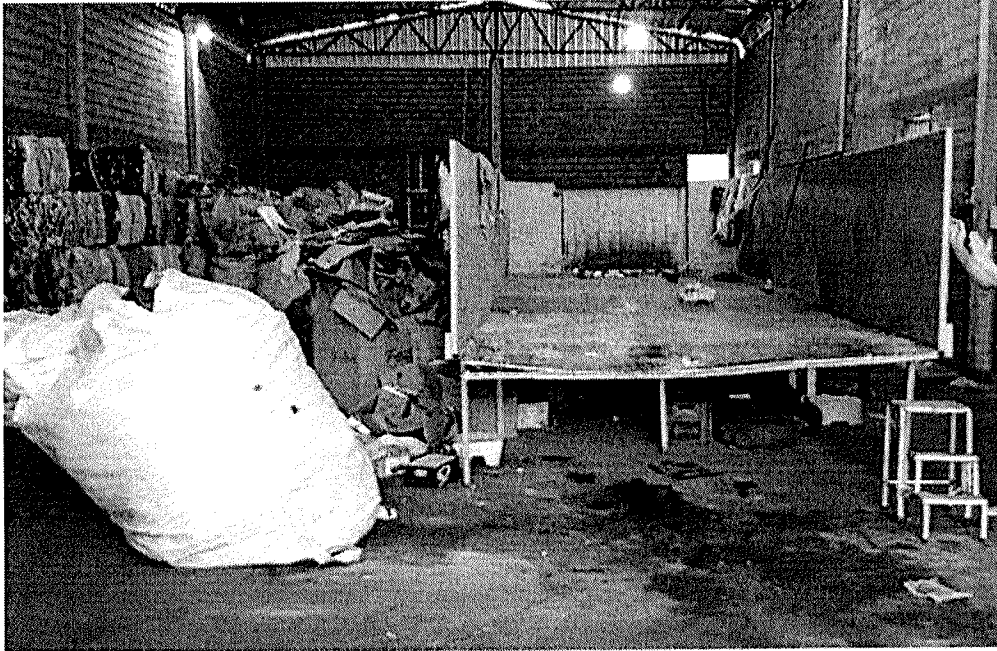
Foto 03: Bandeja de descarga dos resíduos. Fonte: Equipe Ideal, 2019.
